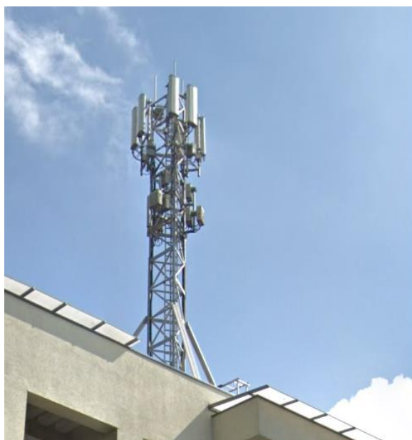
Rysunek 4. Stacje bazowe telefonii komórkowej na dachu budynku oraz wolnostojąca
